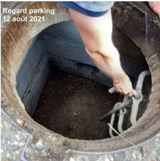
Fond des regards du parking recouvert par 10/20 cm de débris.
