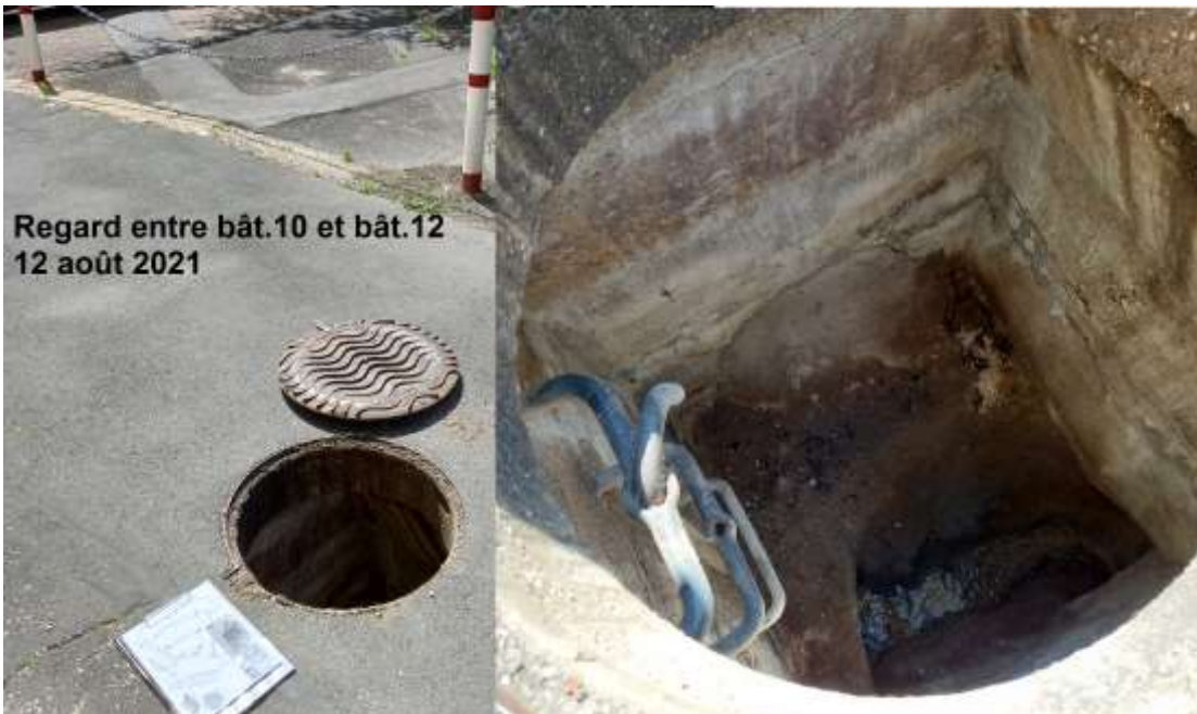
Fond des regards du parking recouvert par 10/20 cm de débris.
